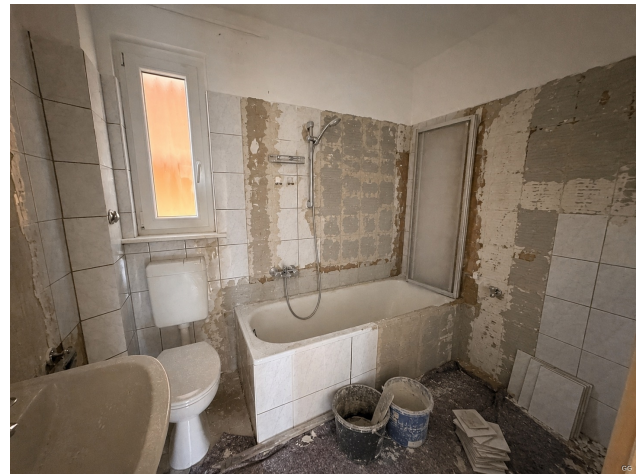
Bad im Umbau
